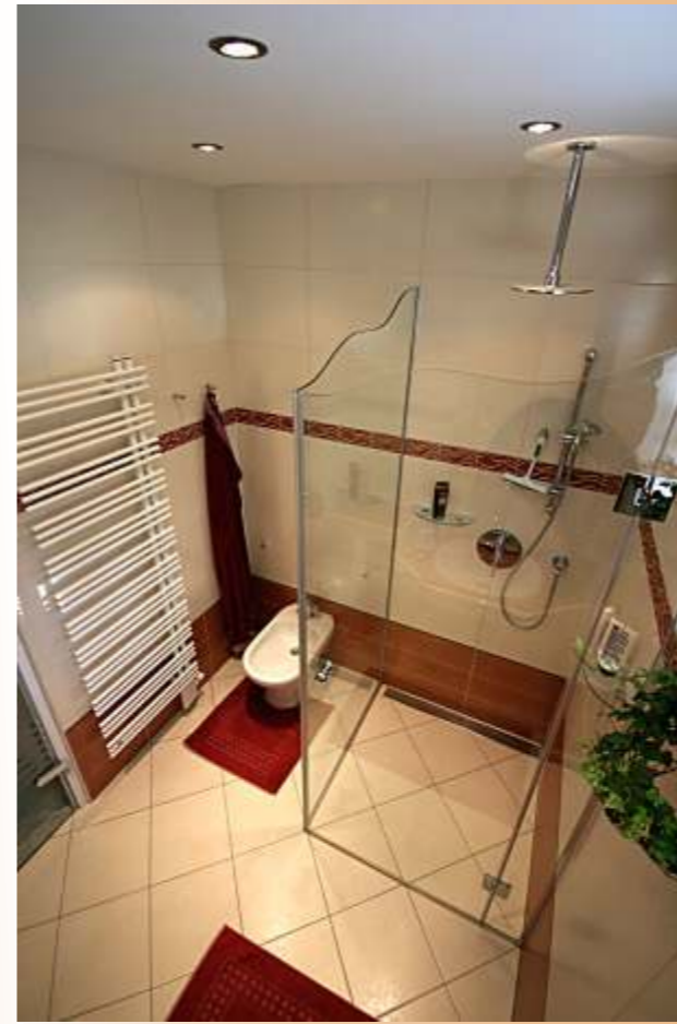
Die geflieste Dusche erlebt eine Renaissance. Hier in Kombination mit einer Duschrinne und einer Glaswand im Wellendesign passend zur Bordüre.
