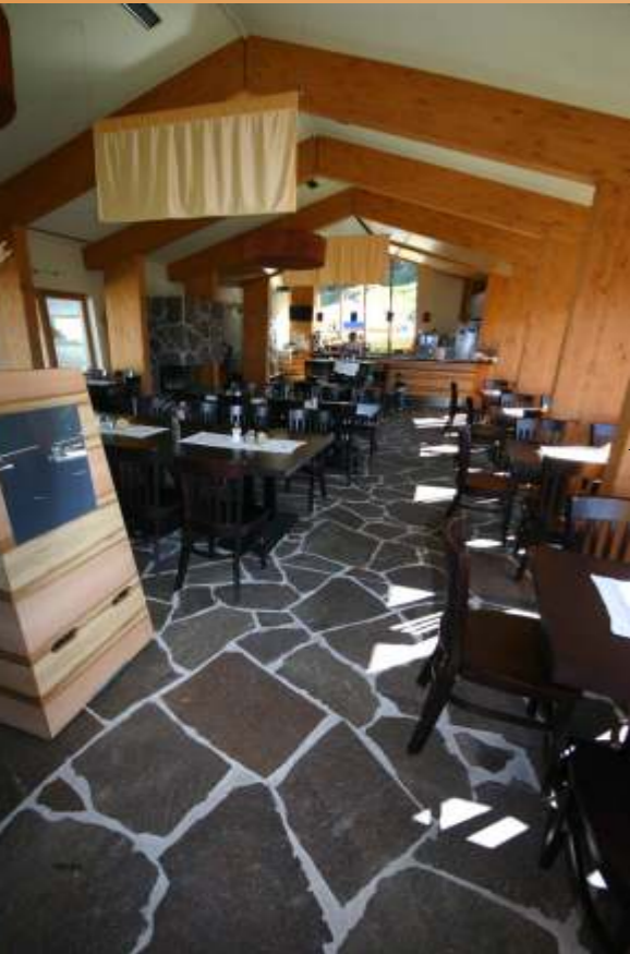
Polygonalplatten aus Porphyrt im Liechtensteinhaus/Semmering.
