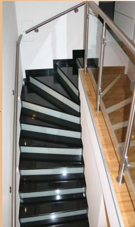
Trittstufen aus Basalt in Puma Black. Die Vorderseite wurde mit weiß lackiertem Glas ausgeführt.
